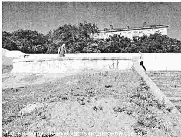
Вид на загруженную часть подпорной стены
